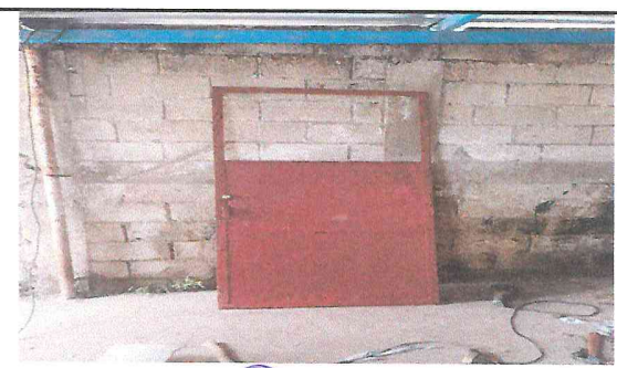
Foto 6: puertas EN PROCESO DE REMOZAMIENTO
