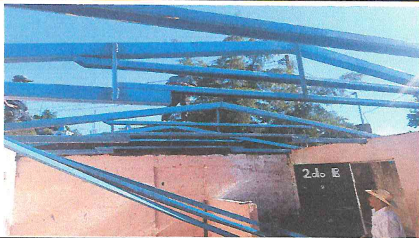
Foto 3: techo de aula REMOZADO Y PINTADO SUSTITUTO DE MADERA POR METAL
